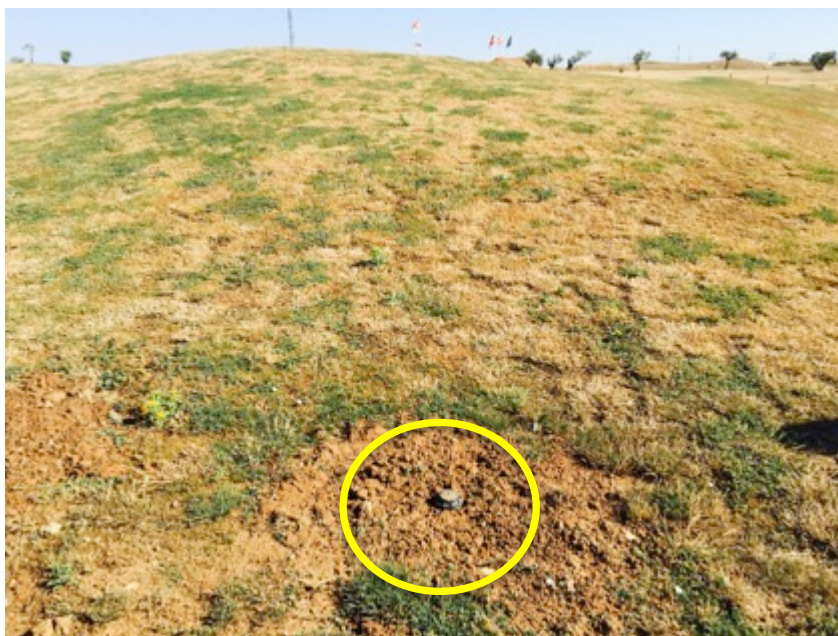
Imagen 16. Aspersor nuevo instalado en el antegreen del hoyo #8.
