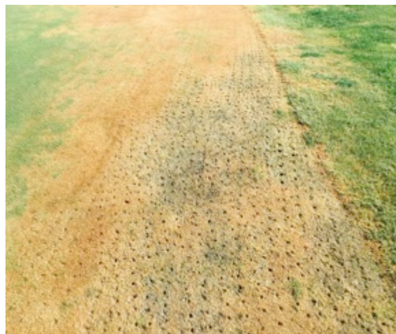
Imágenes 4 y 5. Zonas de talud con problemas de retención de humedad e infiltración que se están pinchando manualmente.
