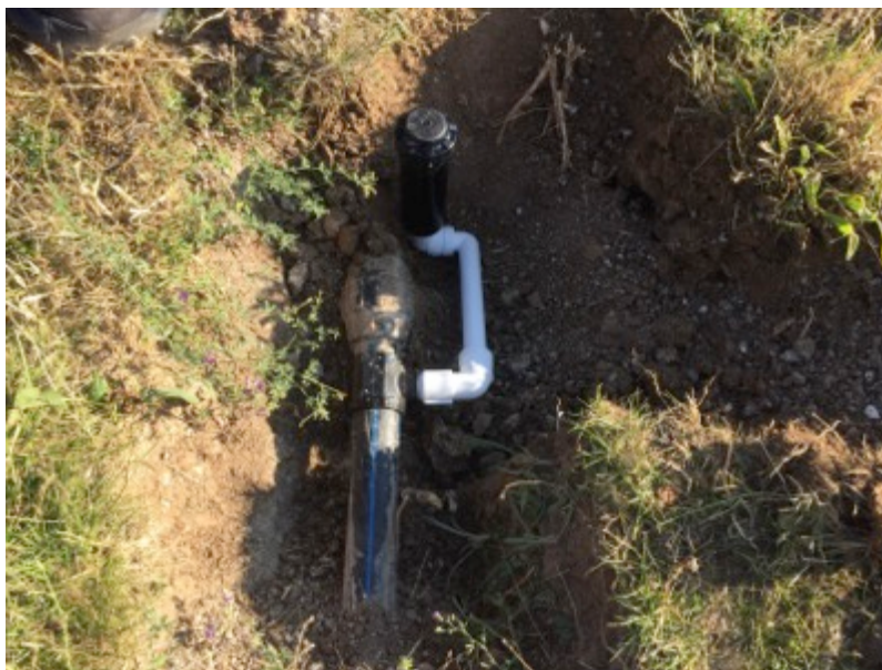
Imagen 11. Aspersor nuevo instalado en el antegreen del hoyo #8.
