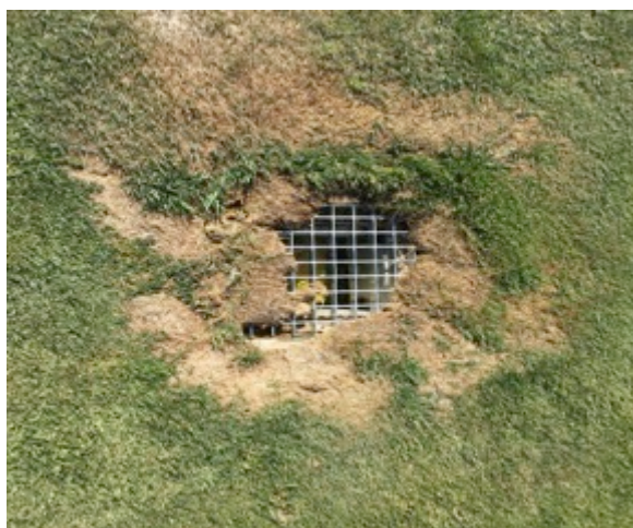
Imagen 13. Colectores casi tapados por el césped.
