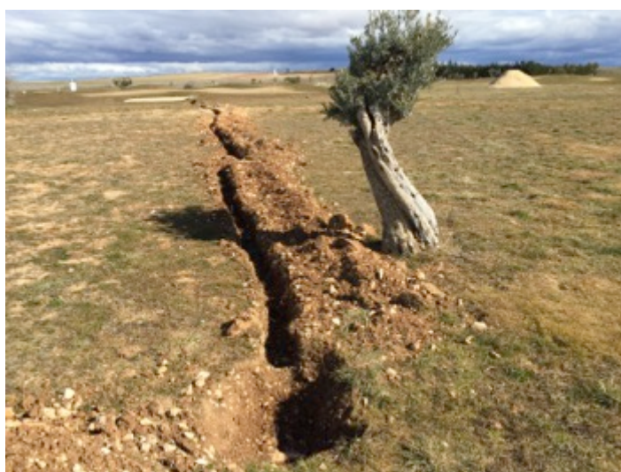
Foto 10: Zanja abierta para la instalación de una toma de una llave de riego.
