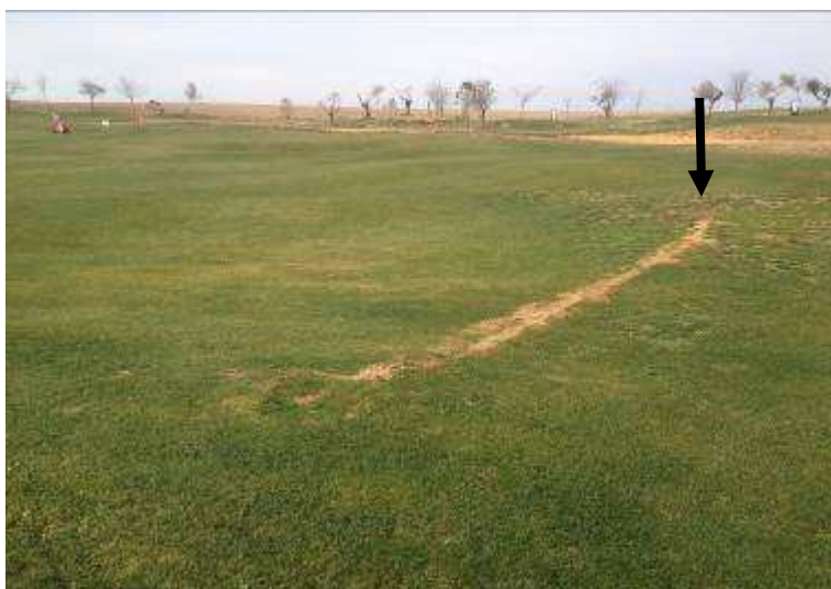
Incorporación de nuevo aspersor calle 7
