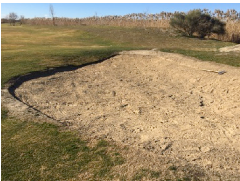
Foto 9: Aspecto general que presentan los bunkers perfilados.
