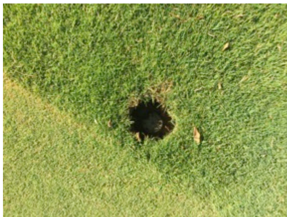
Imagen-18. Cerco del aspersor limpio pero el aspersor está enterrado.
