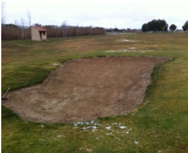
Foto 8: Aspecto general que presentan los bunkers una vez limpiados, perfilados y rastrillados.
