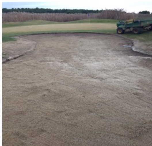
Foto 8: Aspecto general que presentan los bunkers una vez limpiados, perfilados y rastrillados.
