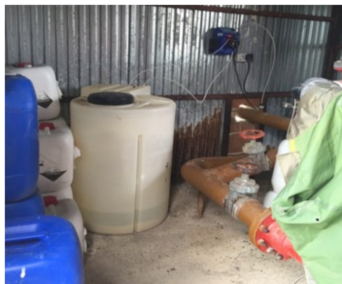
Imagen 19: Inyector de hipoclorito sódico.
