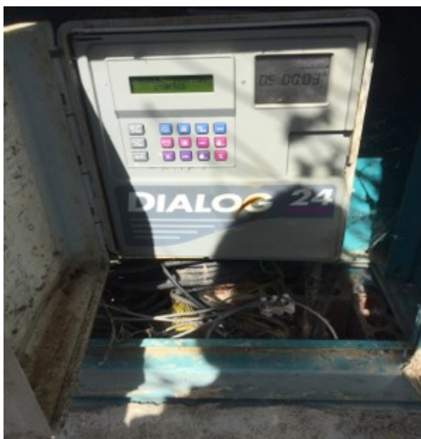
Imágenes 15-16: Programador en un estado de conservación muy deficiente, con cable sueltos y conexiones desordenadas.
