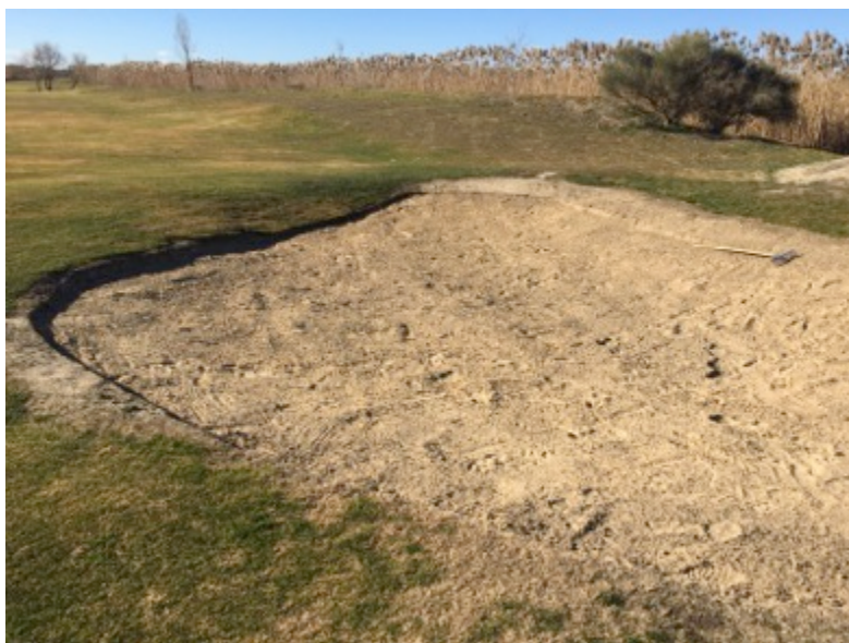
Foto 15: Aspecto general que presentan los bunkers una vez limpios y perfilados los bordes.
