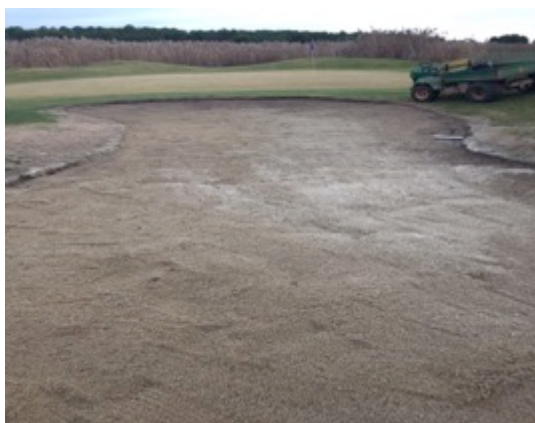
Imagen 4. Estado general de los bunkers
