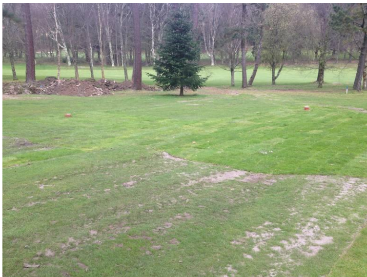
Foto 17. Zona de calle del hoyo 10 con nuevo sistema de drenaje.
