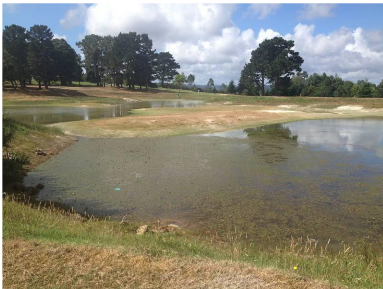
Foto 6. Lago del hoyo 3 en el que se observa el bajo nivel de agua acumulada.
