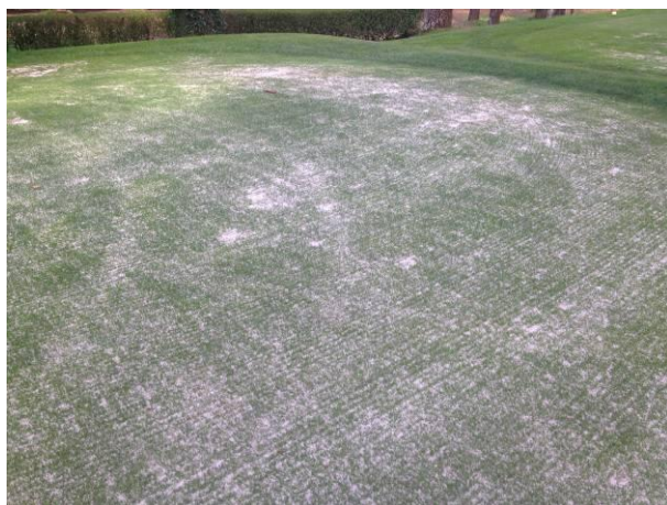
Foto 8. Plataforma de tee hoyo 18 en Marzo.
