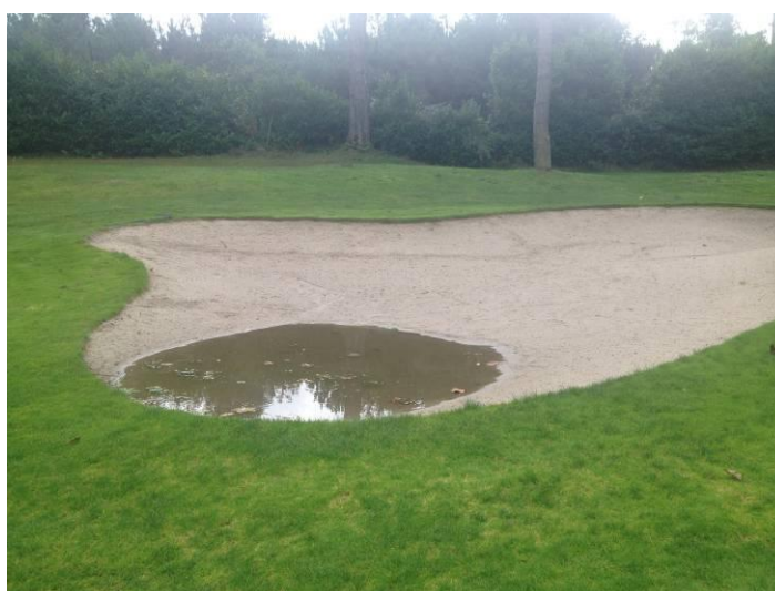
Foto 13. Agua acumulada en un bunker del recorrido.
