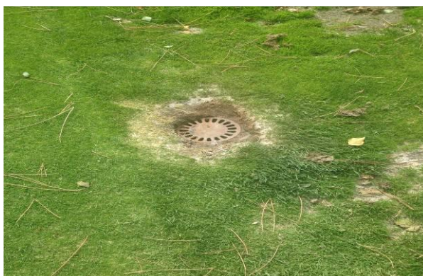
Foto 14. Arqueta tras la labor de limpieza.
