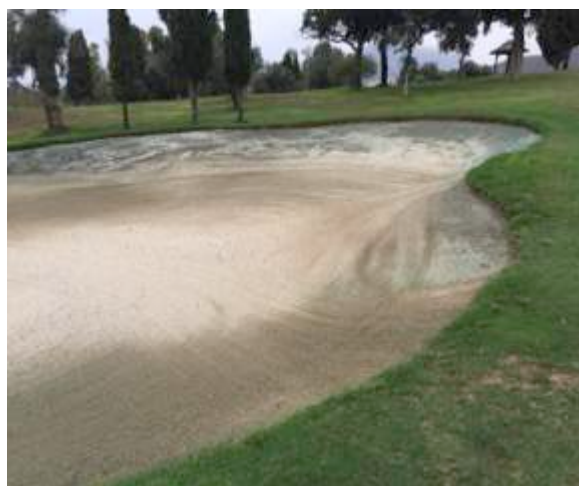
Evidentes problemas de drenaje y falta de arena en las paredes de los bunkers.
