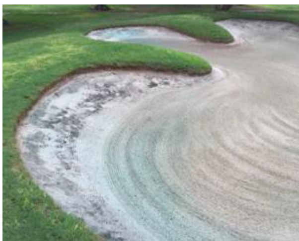
Evidentes problemas de drenaje y falta de arena en las paredes de los bunkers.
