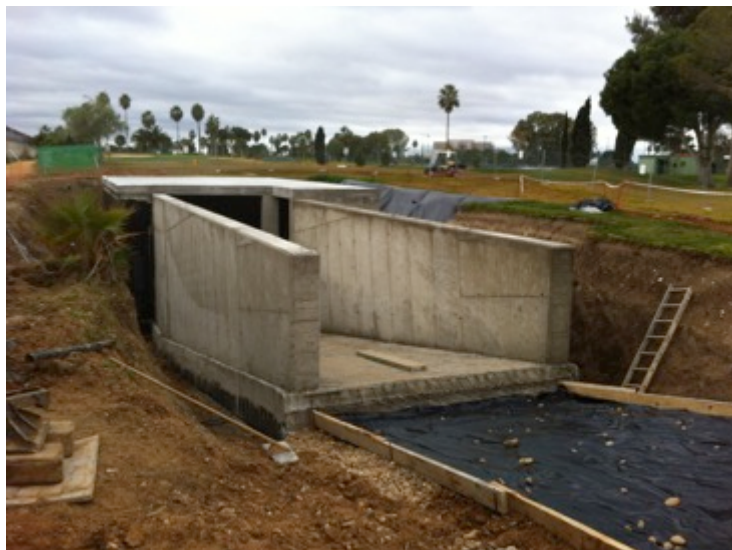
Foto 13: Construcción de la nueva estación de bombeo.
