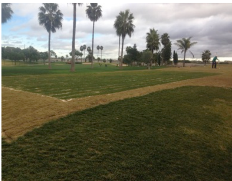
Fotos 7: Nueva plataforma terminada del hoyo 9 (drcha.)
