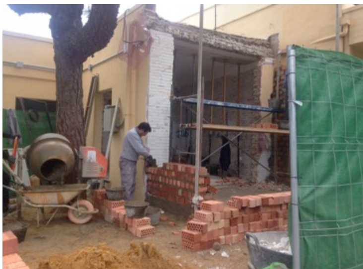
Foto 14: Trabajos de construcción de la oficina de torneo.
