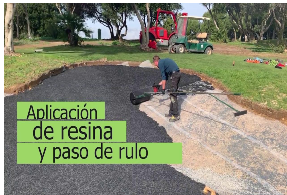
Nueva construcción Bunkers
